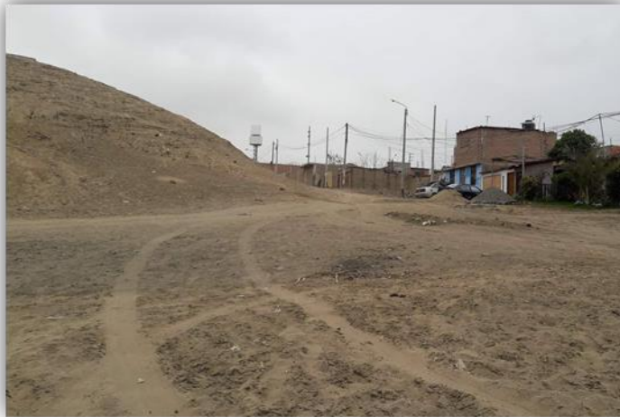
Figura A-06. Déficit de Infraestructura Urbana Fuente: Archivo personal-2018
