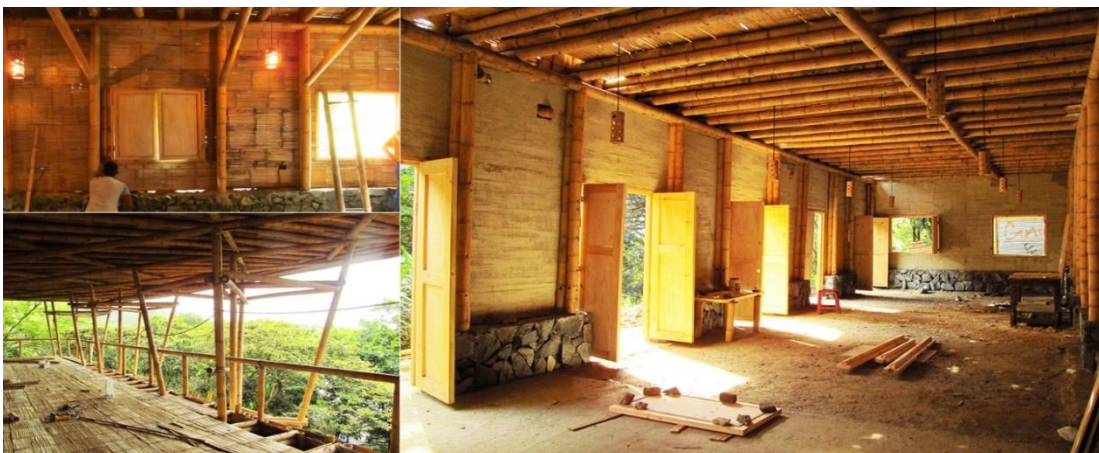
Figura 23. Vista interior del Colegio de las Aguas.
