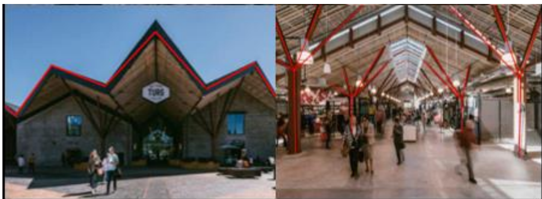
Figura 26: Cubierta del Mercado Estación Báltica
