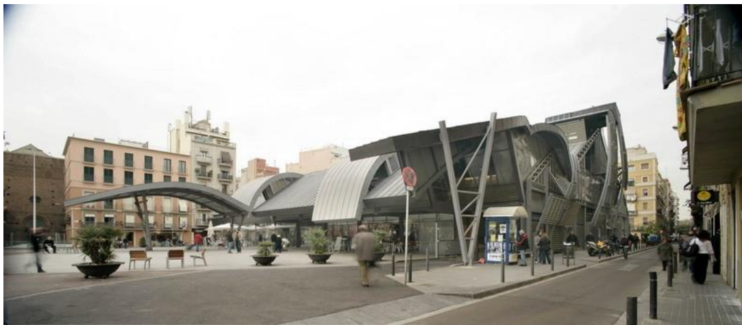
Figura 24: Cubierta del Mercado La Barceloneta
