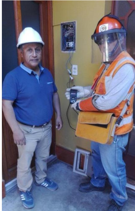
Registrador de tensión instalado en la llave térmica del cliente
