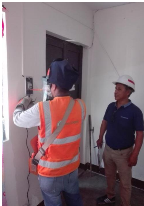
Registrador de tensión instalado en la llave térmica del cliente
