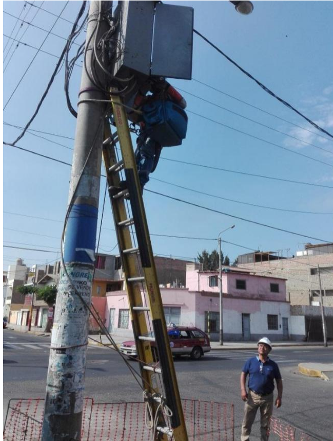
Instalando el analizador de redes
