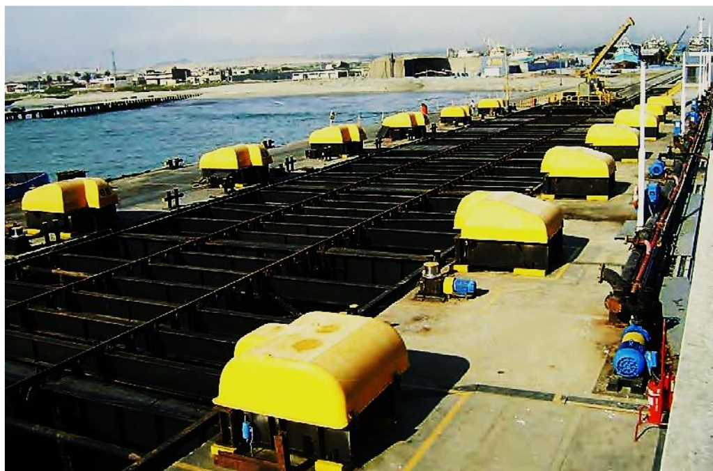
Figura 4. Plataforma Syncrolift / disposición actual de los winches.
