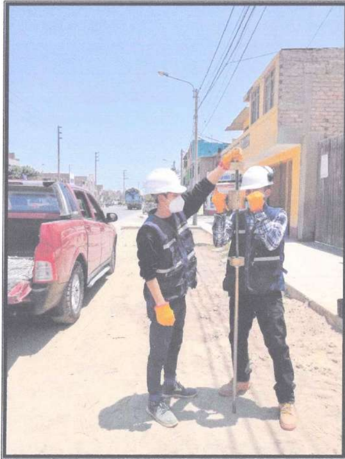
ENSAYO IN SITU DE DPL N°2
