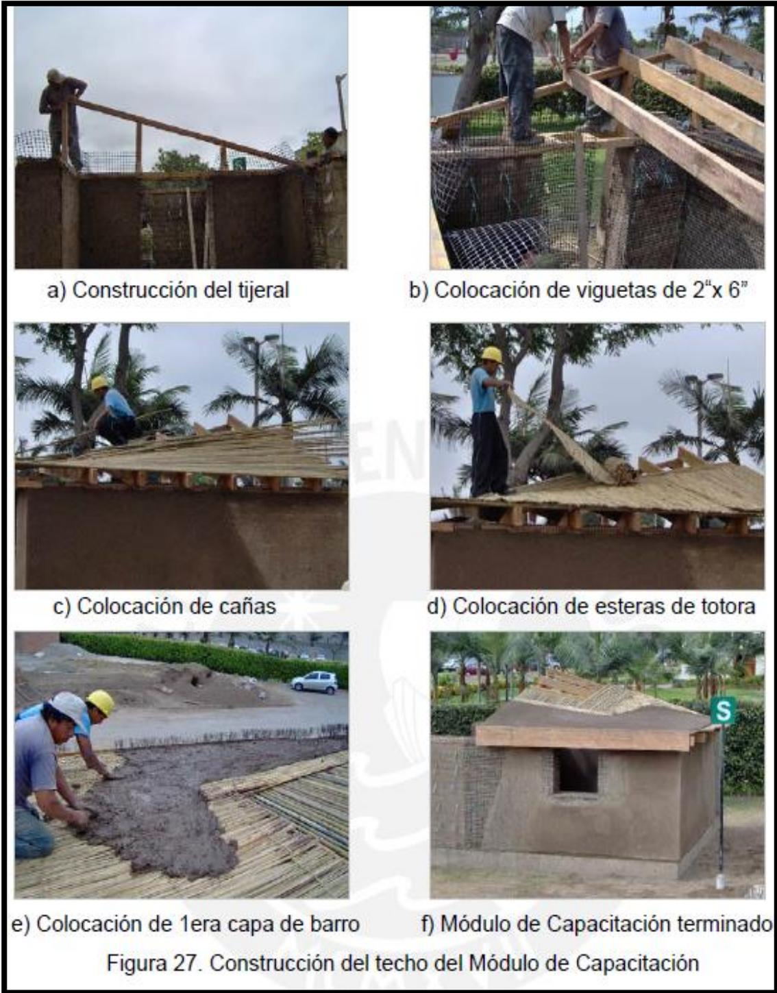
Figura 43. Construcción del techo del módulo.
