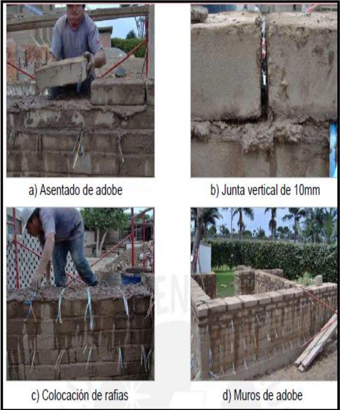
**Figura 39.** Construcción de muros de adobe.
