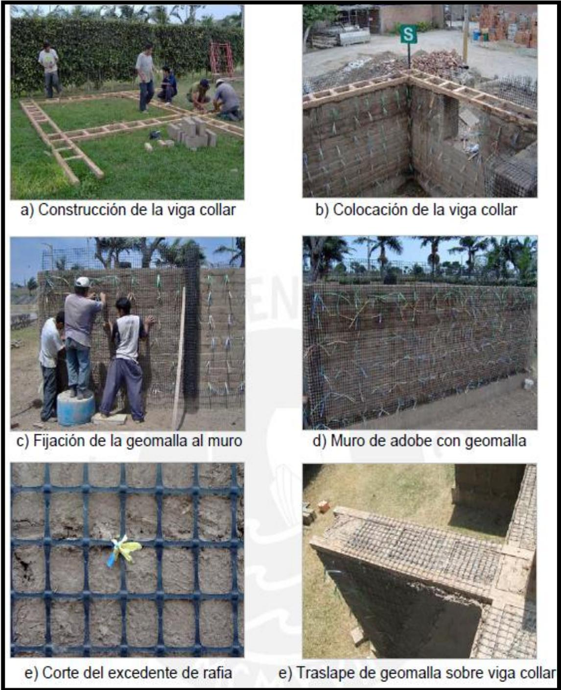
**Figura 40.** Colocación de viga y geomalla.
