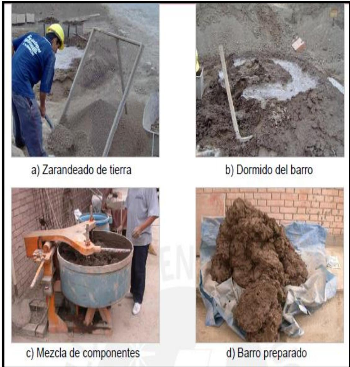
*Figura 34.* Preparación del adobe para fabricar adobes.
