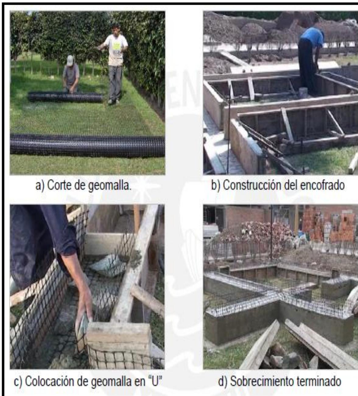
**Figura 37.** Construcción del sobre cimiento
