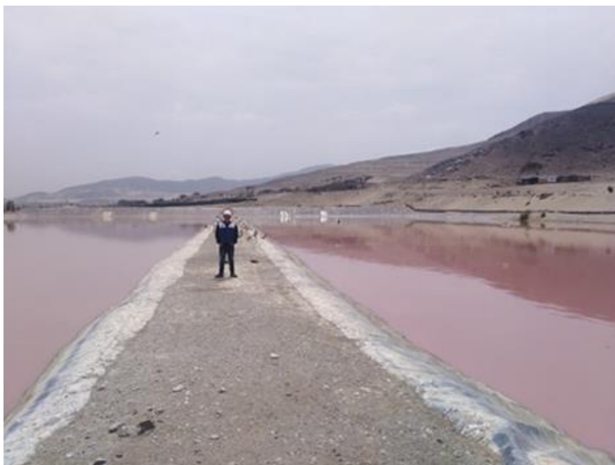
Figura N°17. Parte central de las 2 posas de salida de la laguna de oxidación.
