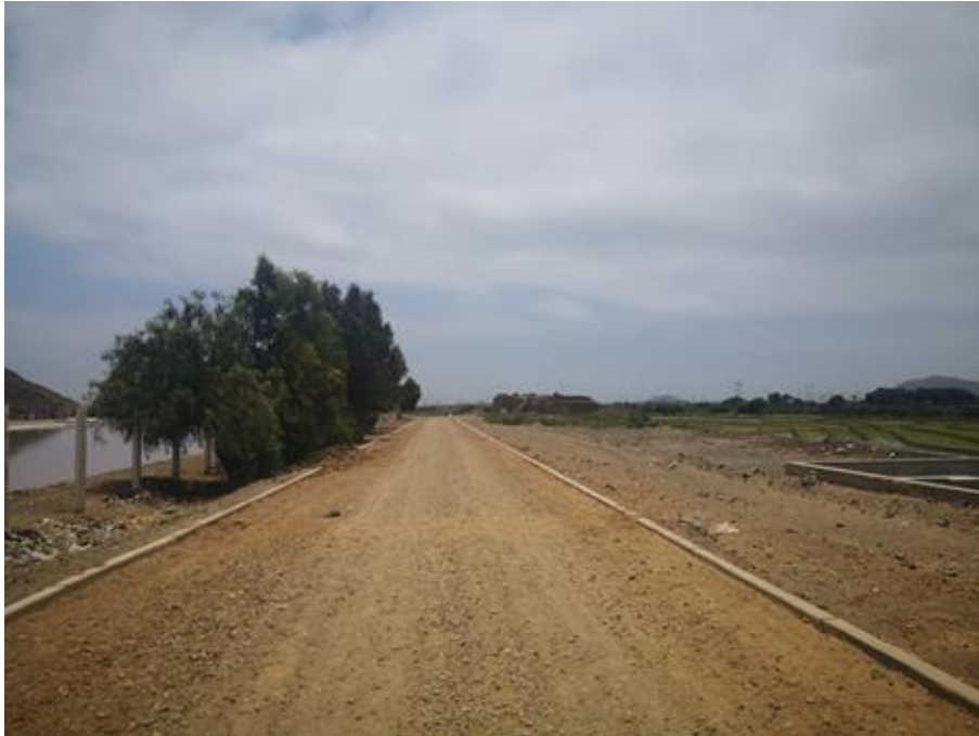
Figura N°15. Entrada a la laguna de oxidación de Coishco
