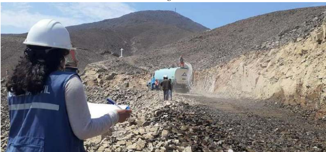
Fotografía 15. Toma de datos de la partida 01.03.05 Conformación y Compactación de Sub-rasante con maquinaria [Humedecimiento del terreno]
