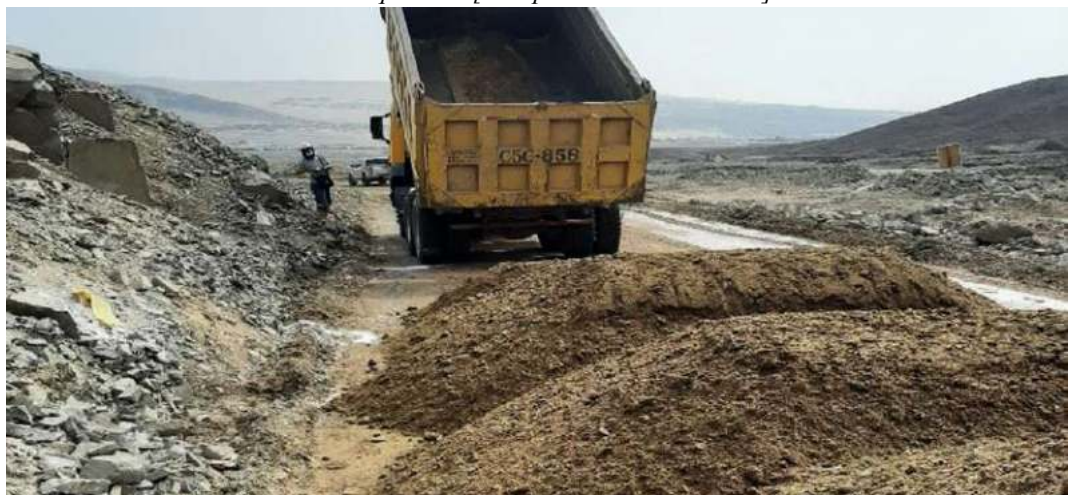
Fotografía 12. Toma de datos de la partida 01.04.01 Sub base granular
