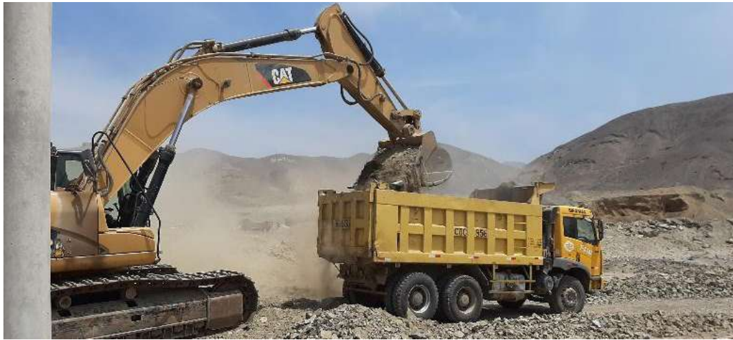
Fotografía 08. Toma de datos de la partida 01.03.06 Eliminación de desmonte existente sobre terreno natural.
