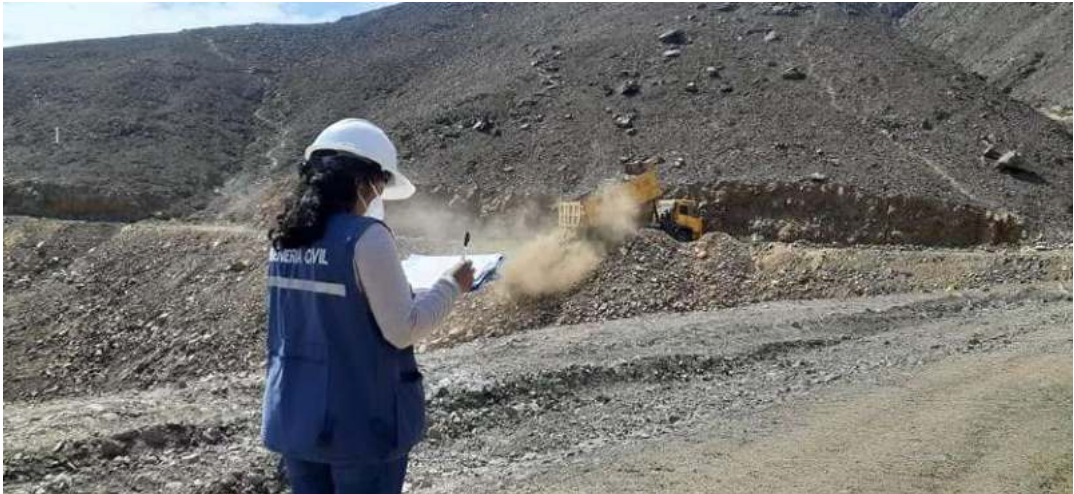
Fotografía 16. Toma de datos de la partida 01.03.07 Eliminación de material excedente con volquete
