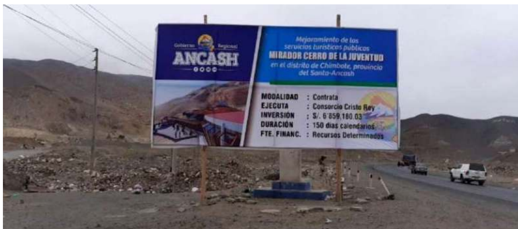
Fotografía 01. Cartel de obra ubicado en un punto estratégico para cumplir su función de informar al público sobre la ejecución de la obra.
