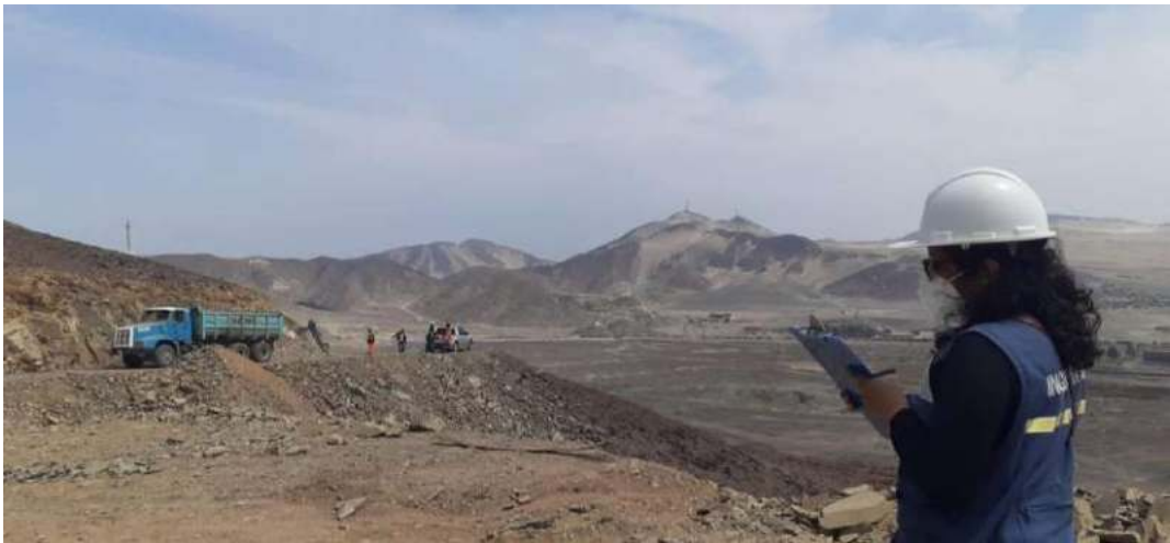
Fotografía 14. Ubicación de un punto estratégico para la toma de datos entre las progresivas 2+100 al 3+500 en el lugar de estudio.
