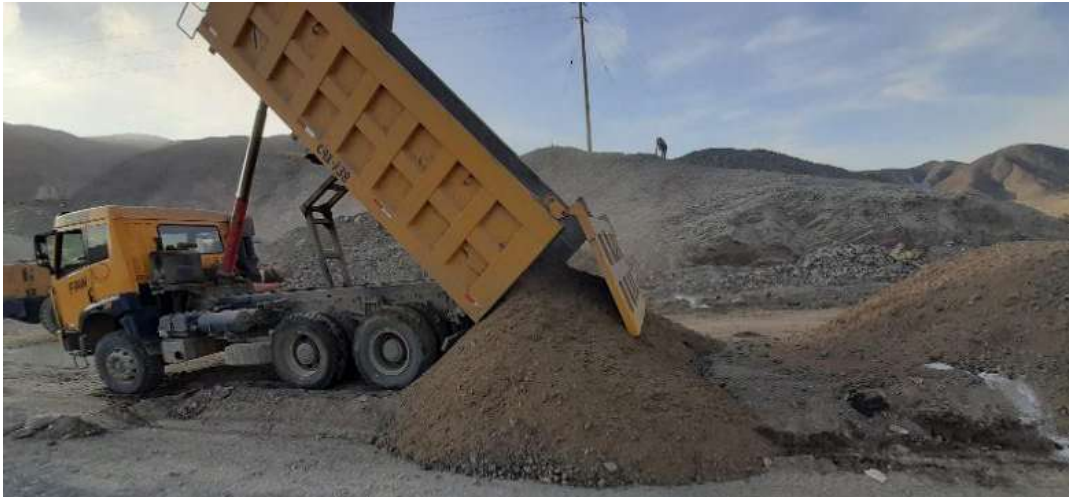
Fotografía 10. Toma de datos de la partida 01.03.04 Relleno con material propio con maquinaria
