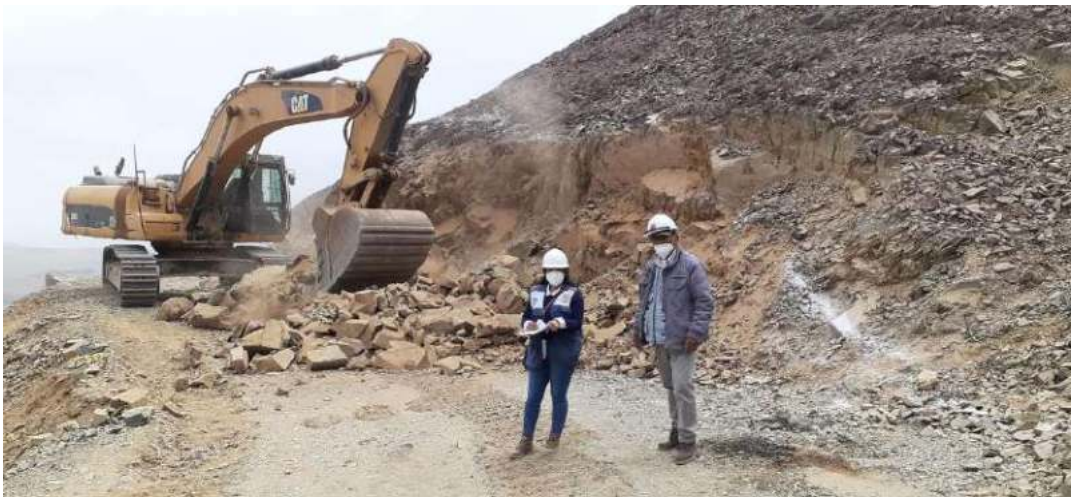
Fotografía 17. Asesorada junto al Ingeniero Residente de la Obra.
