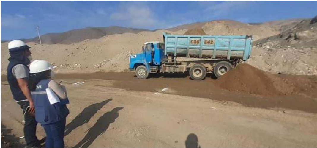
Fotografía 13. Toma de datos de la partida 01.04.02 Base granular
