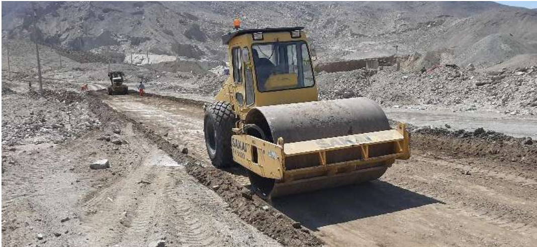
Fotografía 11. Toma de datos de la partida 01.03.05 Conformación y Compactación de Sub-rasante con maquinaria [Compactación del terreno]
