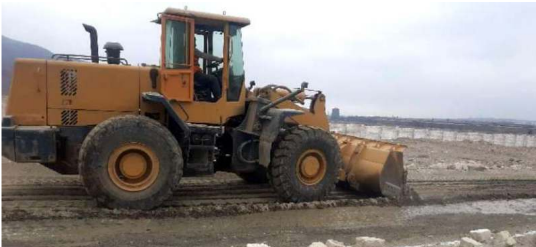
Fotografía 09. Toma de datos de la partida 01.03.01 Corte de Material en terreno suelto con máquina
