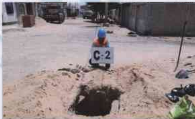
VISTA PANORAMICA DE LA CALICATA C- 2 EN LA ZONA EN ESTUDIO – A.H. NUEVA ESPERANZA.
