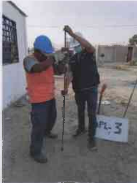
VISTA DEL ENSAYO DE PENETRACION LIGERA DPE-3 EN LA ZONA EN ESTUDIO - A.N. NUEVA ESPERANZA
