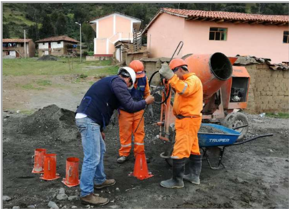
Figura N° 26: Utilización de Cono de Abrams de concreto patrón.
