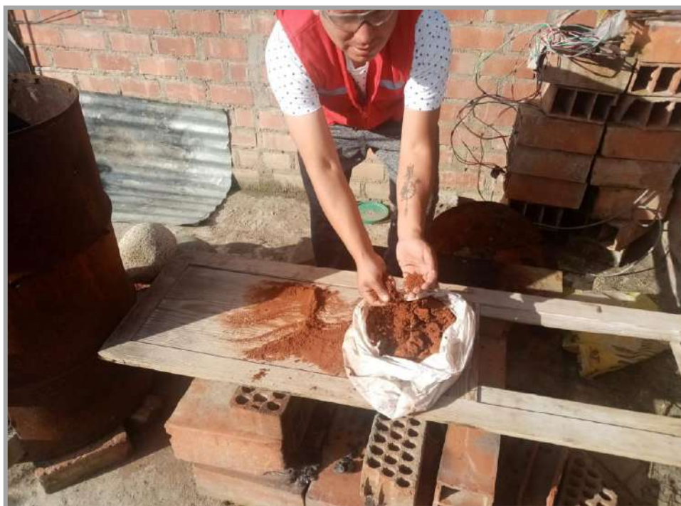
Figura N° 21: recolección de producto final del molido de cerámico reciclado molido.
