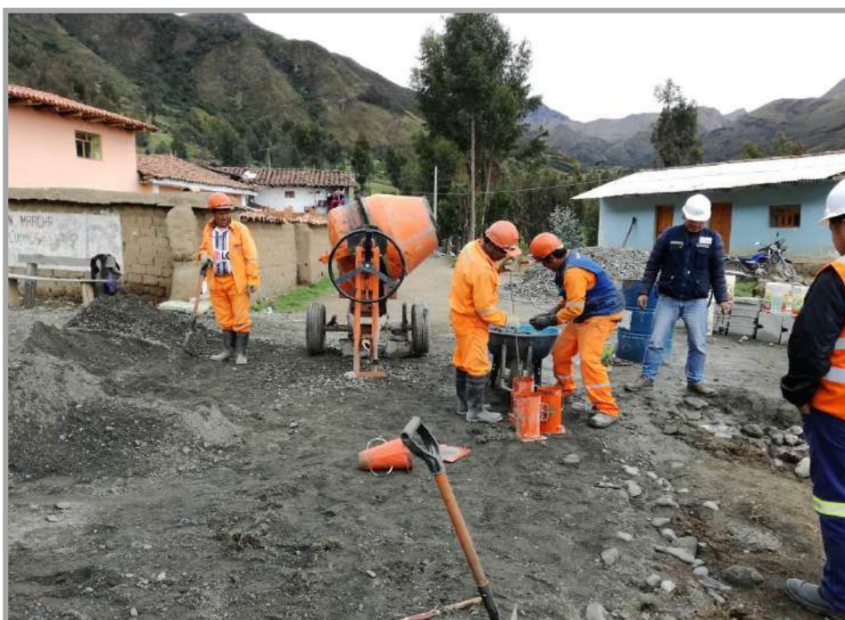
Figura N° 22: Material (arena y piedra) y preparación de concreto patrón.
