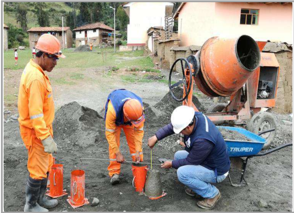
Figura N° 23: Midiendo el SLUM del concreto patrón – 3”.
