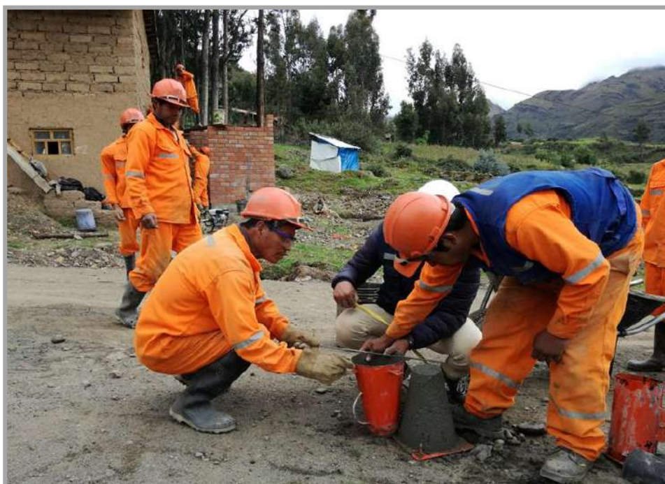
Figura N° 27: Midiendo el SLUM del concreto experimental sustitución del cemento en 10%.
