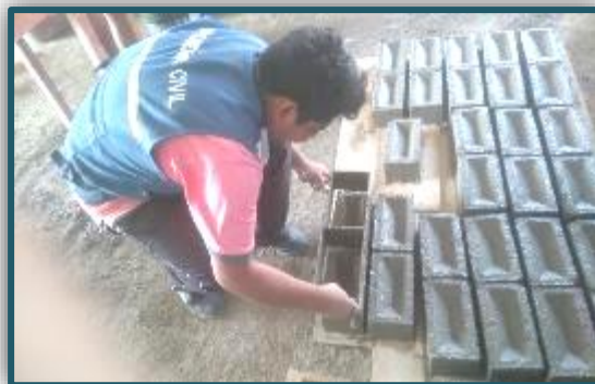
Figura 25. Desencofrado de la unidad de ladrillo Fuente: Elaboración Propia
