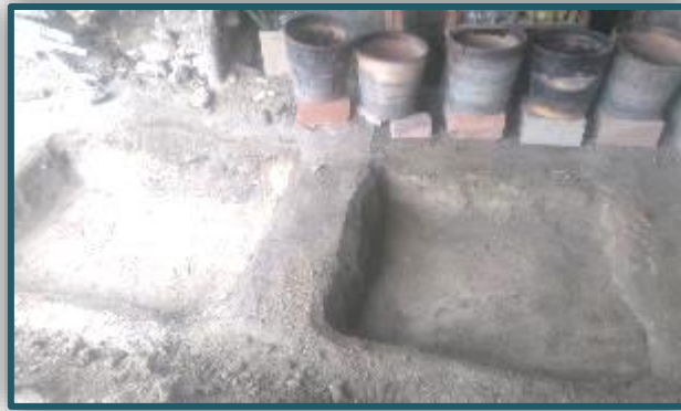
Figura 32. Acondicionamiento para curado del ladrillo
