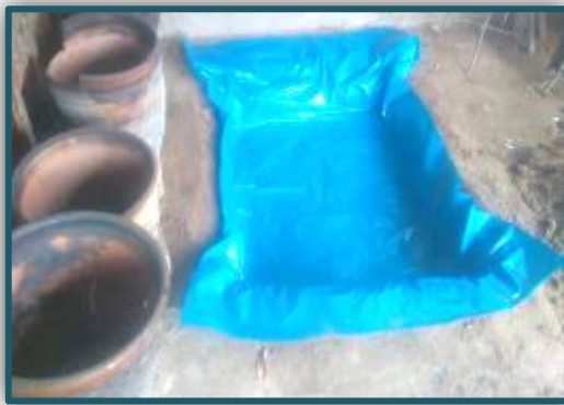
Figura 33. Impermeabilizando poza Fuente: Elaboración Propia
