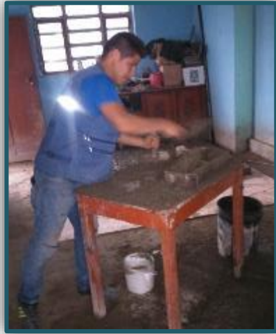
Figura 22. Moldeado del ladrillo Fuente: Elaboración Propia
