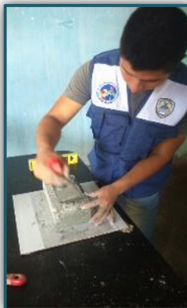
Figura 37. Nivelación de caravistas Del ladrillo Fuente: Elaboración Propia
