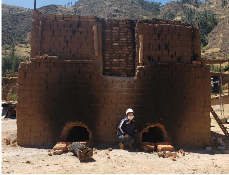
Figura 18: túnel de ventilación del horno artesanal - ladrillera Santa Rosa – CPM San Nicolás - Huaraz
