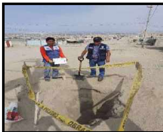
Figura N°3: Vista de la calicata C-3 entre la intersección de la avenida 1 y calle 15, AA-HH Los Constructores.
