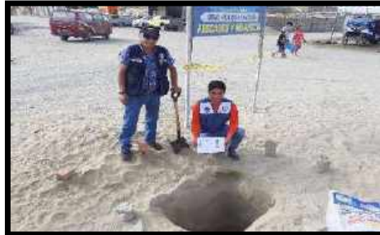
Figura N°1: Vista de la calicata C-1 entre la intersección de la avenida 1 y calle 12, AA-HH Los Constructores.
