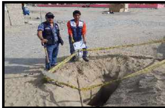
Figura N°2: Vista de la calicata C-2 entre la intersección de la avenida 1 y calle 13, AA-HH Los Constructores.
