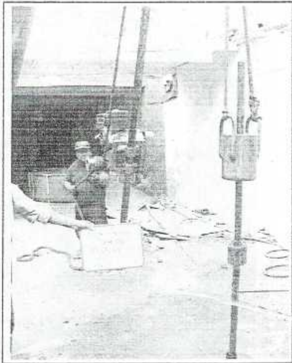
Foto N°06: Vista de ubicación del SPT-01, ensayo de resistencia a la penetración a los 8.00m de profundidad. Presencia de arena mal graduada con limos (SP-SM), muy compacto, satura de color beige oscuro.
