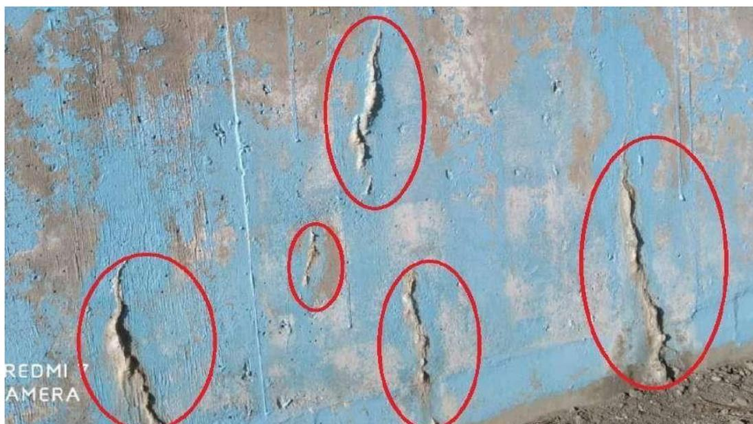
**-Figura:** Las fisuras en elementos de concreto es de recurrencia diaria y no existe obra realizada en concreto que no presente esta patología.
