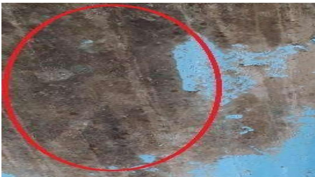
**-Filtración:** La humedad ocasionada por filtraciones es un tipo de patología muy común, el cual es producida por exceso de fisuras o grietas.
