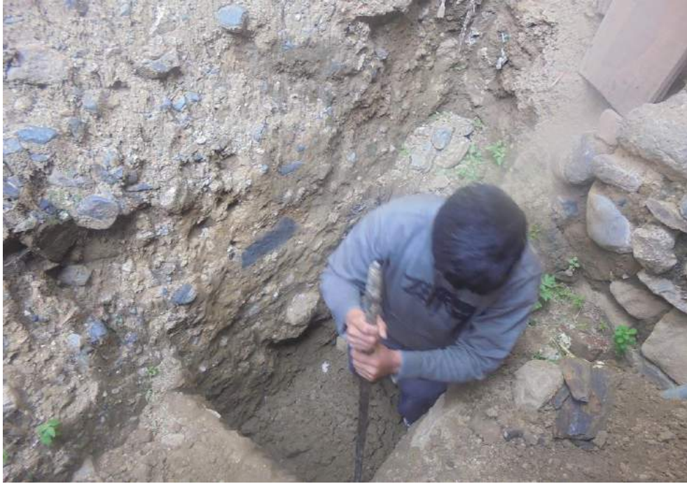
FIGURA N° 68: Vista de preparación de calicatas en el terreno de estudio para extraer la muestra de Suelo para el estudio.
