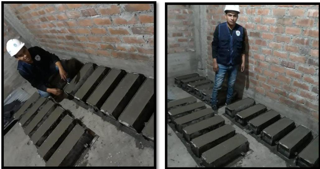
Figura 12: Llenado de las viguetas patrón y a los de ensayo
