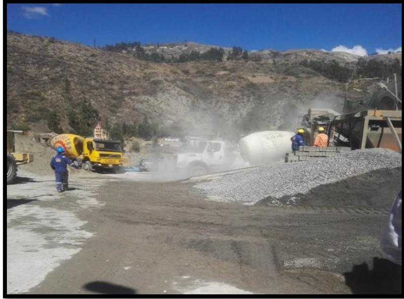
Figura 3: Adquisición de agredo fino
