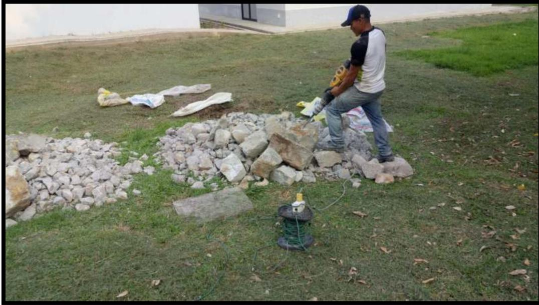
**Figura 63.** Trituración de concreto extraído del pavimento rígido siendo triturado con martillo hidráulico.
