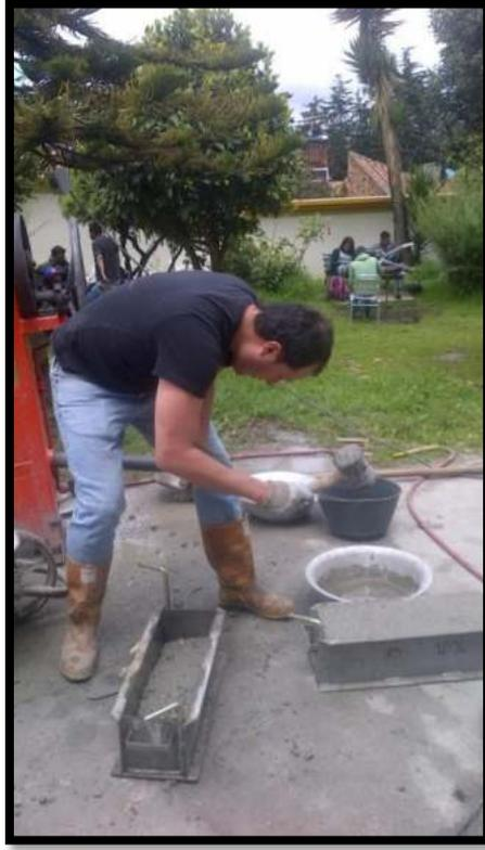
**Figura 85.** Vibrado de Concreto – viguetas
