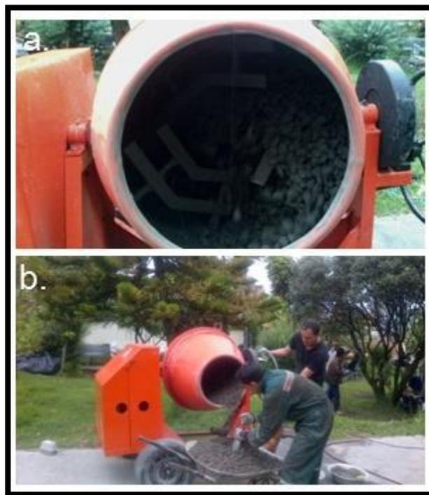
**Figura 82.** (a) y (b) Mezcla de concreto con agregado fino reciclado de concreto y agregado grueso de origen ígneo.
