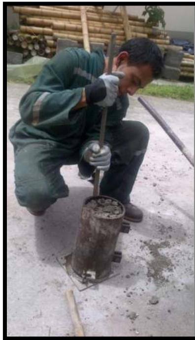
**Figura 84.** Vibrado de concreto – Briquetas
