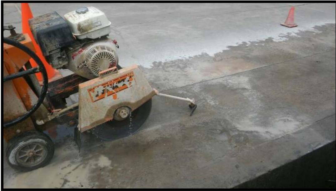
**Figura 61.** Se puede observar la rotura de pavimento rígido, con la amoladora.
