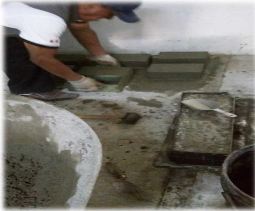
Figura 16. Desmoldeo de ladrillo de concreto
