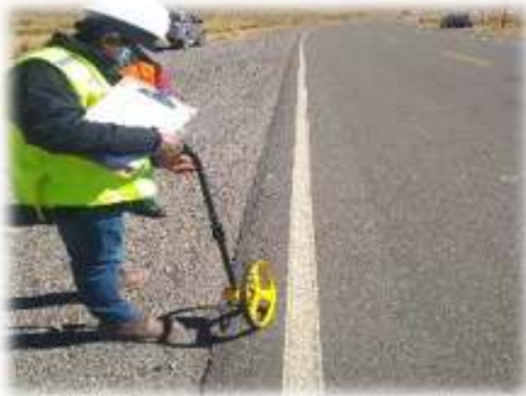
Fotografía N° 02 Recorrido con odómetro de ruedas para marcar las progresivas e identificar las distancias de las fallas y el metrado.
