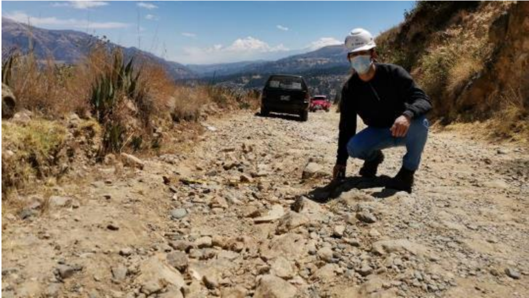
Figura 51: Unidad de muestra N°4 (prog. 1+630 km – 1+720 km). Falla 85 (Baches) según tabla 6 (Nivel B), de cantidad 22.
