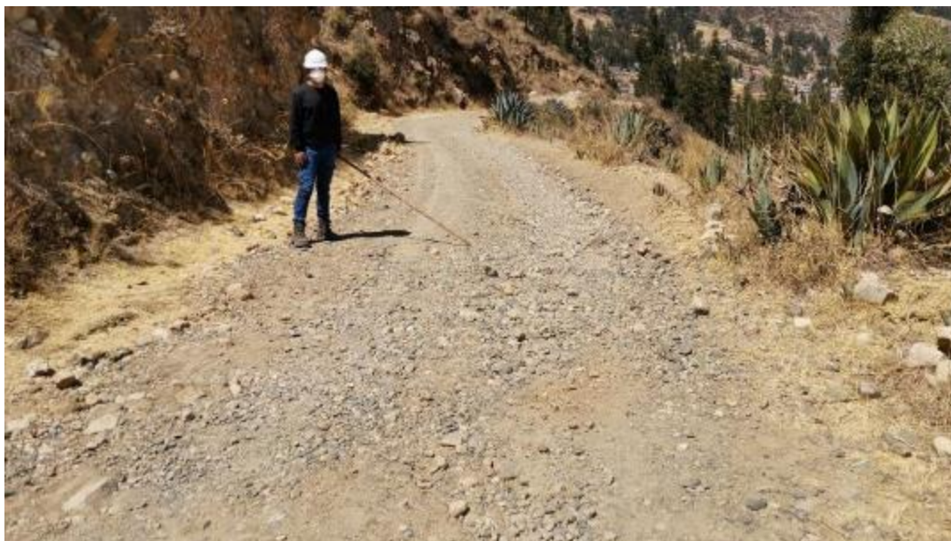
Figura 41: Unidad de muestra N°2 (prog. 0+550 km – 0+630 km). Falla 86 (Surcos) según tabla 6 (Nivel M), de área 32m 2 .
