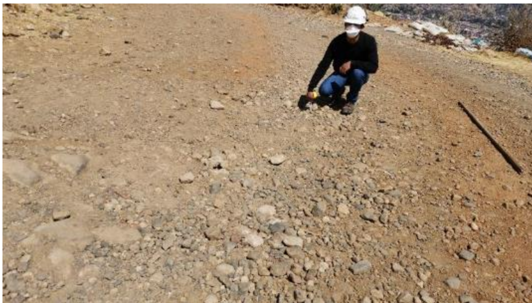
Figura 47: Unidad de muestra N°3 (prog. 1+320 km – 1+420 km). Falla 87 (Surcos) según tabla 6 (Nivel M), de longitud 160 m.
