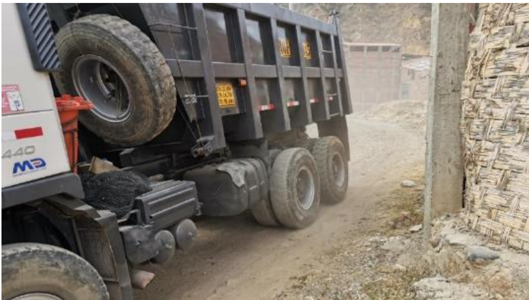
Figura 34: Unidad de muestra N°1 (prog. 0+030 km – 0+080 km). Falla 84 (Polvo) según tabla 6 (Nivel M), de puntuación 4.
