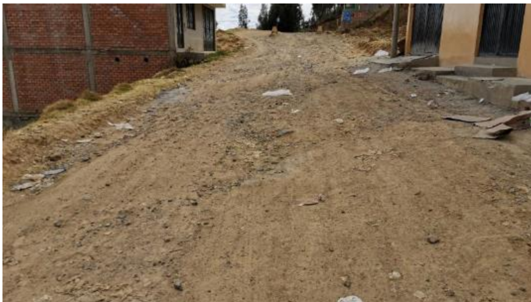
Figura 24: Falla 83 Ondulaciones
