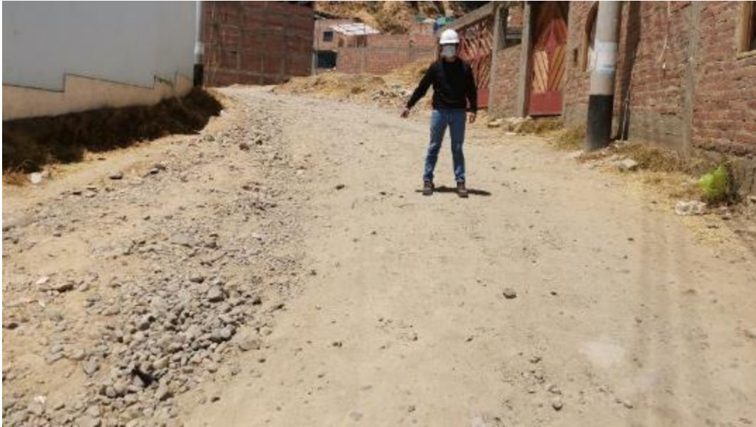
Figura 31: Unidad de muestra N°1 (prog. 0+030 km – 0+080 km). Unidad de muestra N°1. Longitud 50 m, considerando ancho de calzada 6.2 m y área 310 m 2 de acuerdo a la metodología URMM.
