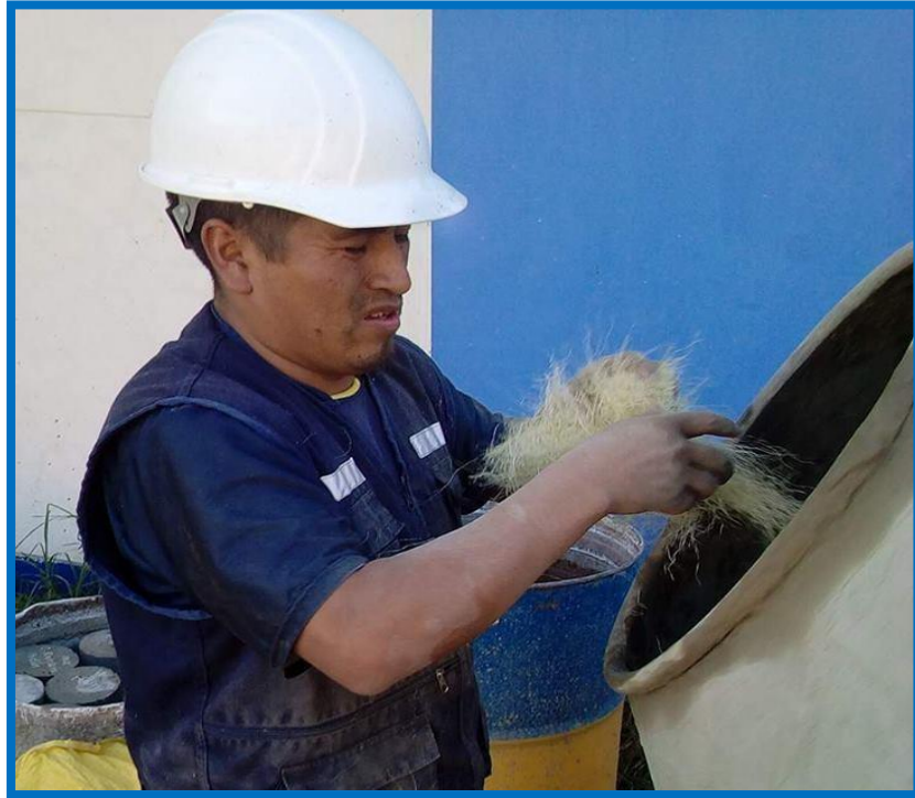
Figura 62: Adición de fibra de agave a la mezcla de concreto
