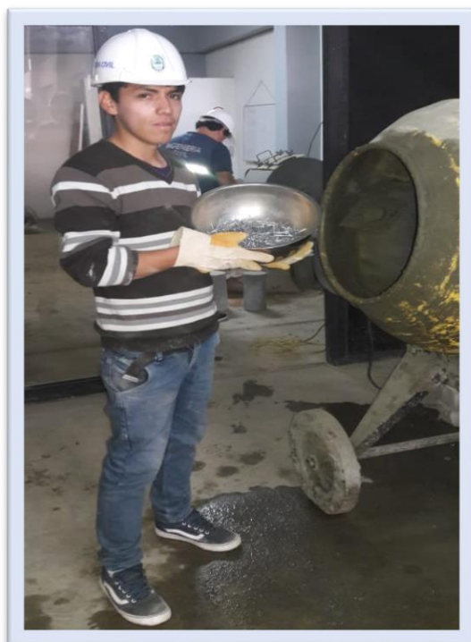
Figura 33 Adición de fibra de alambre 5cm de longitud a la mezcladora
