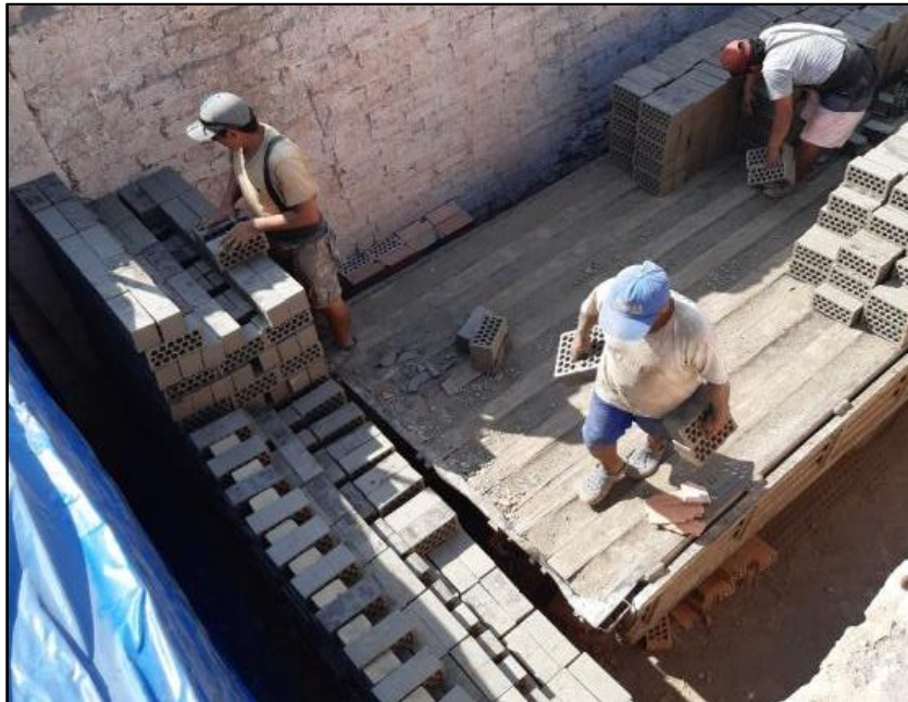
Foto 14. Colocación de los ladrillos patronos y experimentales que serán sometidos a cocción en el horno.
