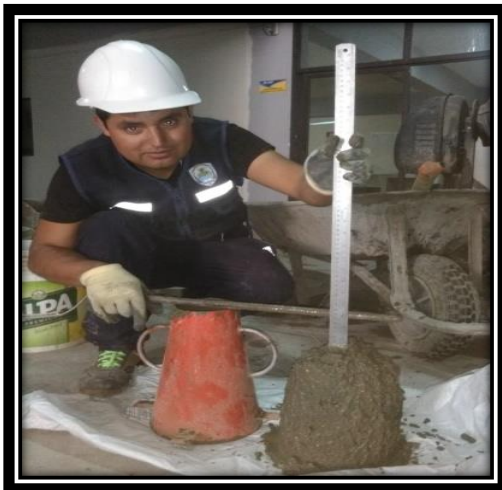
Figura 56. Realizando la medición del slump
