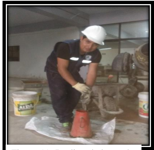
Figura 55.. Realizando la prueba del slump
