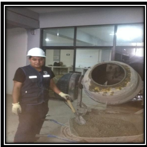
Figura 52. Realizando la mezcla de concreto
