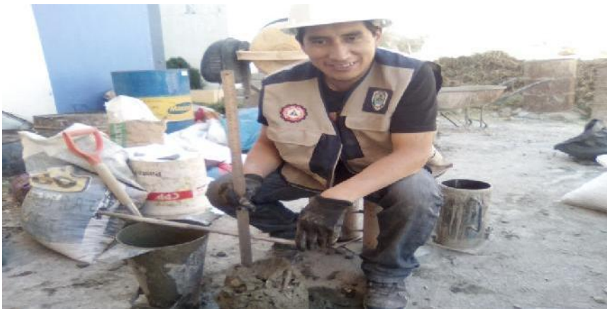
Figura N° 5: Medición del Asentamiento de la mezcla de Concreto.
