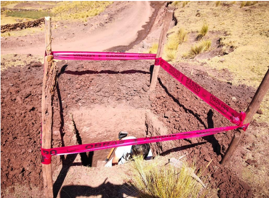
Figura 34. Realizando la excavación en la Calicata C-01 (2020).
