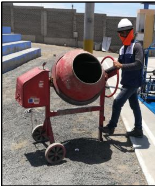
Figura 48. Trompo utilizado para mezclar los materiales
