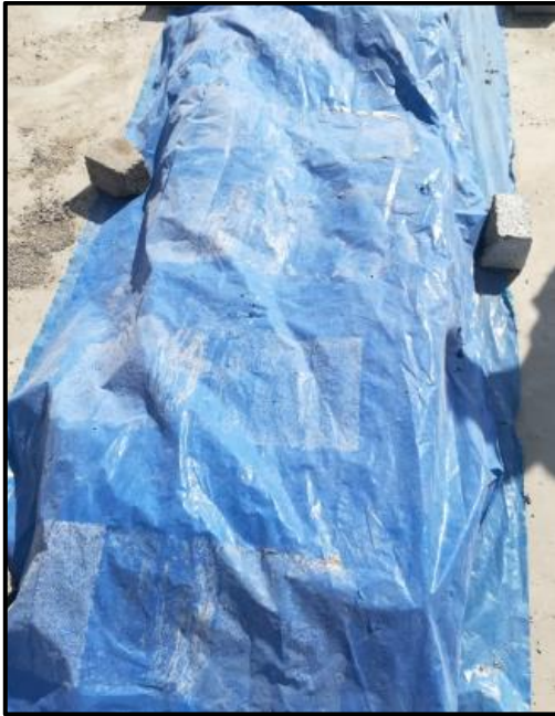
Figura 54. Cobertura con plástico de las unidades durante 24 horas.
