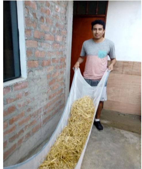
Figura 02: Limpieza de la paja para evitar los limos
