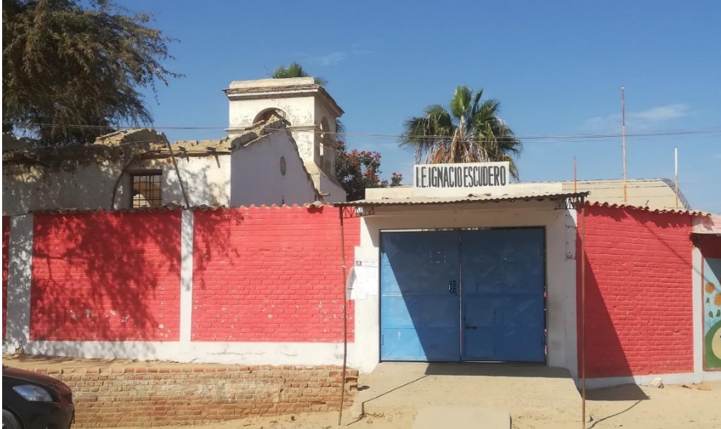
Foto 1: Vista General de Institución Educativa Ignacio Escudero, distrito de Ignacio escudero, provincia Sullana, región Piura
