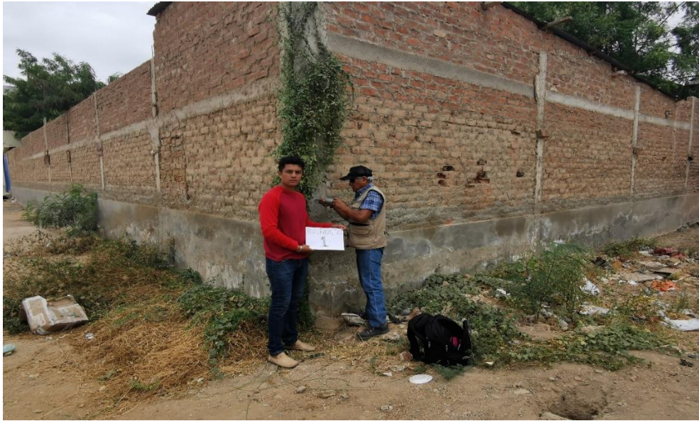
Foto 5: Prueba de esclerometría N°01 de concreto en columna de esquina del cerco perimétrico de la Institución Educativa Ignacio Escudero, Sullana.
