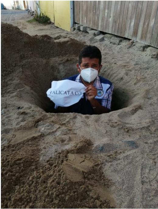
FOTO N°5: IDENTIFICACIÓN DE LA CALICATA 3 A UNA PROFUNDIDAD DE 1.50 M.
