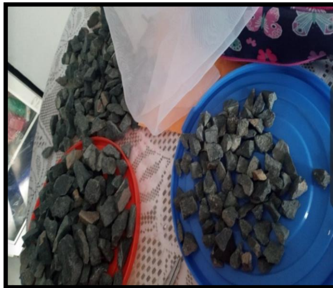
Figura 52. Preparando la grava para biofiltro.
