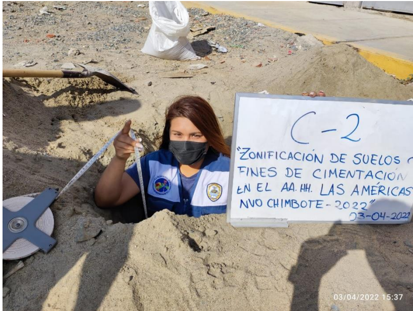
FOTO N°5: EXCAVACIÓN DE LA CALICATA 2
