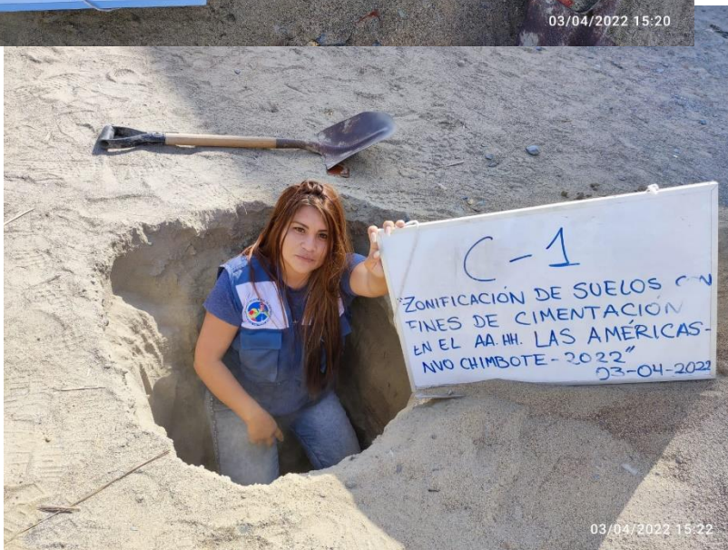
FOTO N°4: EXCAVACIÓN DE LA CALICATA 1
