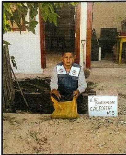
FOTOS : excavación de calicatas
