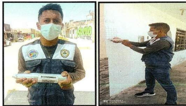
ENSAYO DE ESCLEROMETRIA EN COLUMNAS
