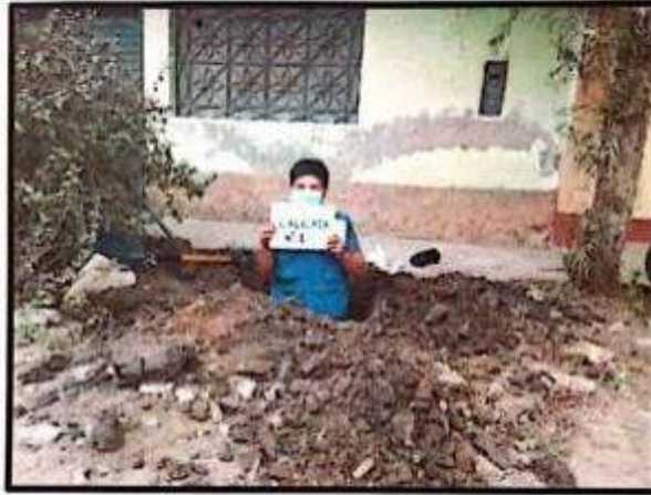
FOTOS : excavación de calicatas
