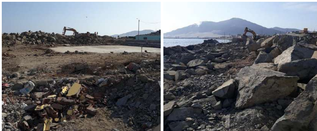
Figura 14. Obra de enrocado en ejecución. Fuente: Elaboración personal
