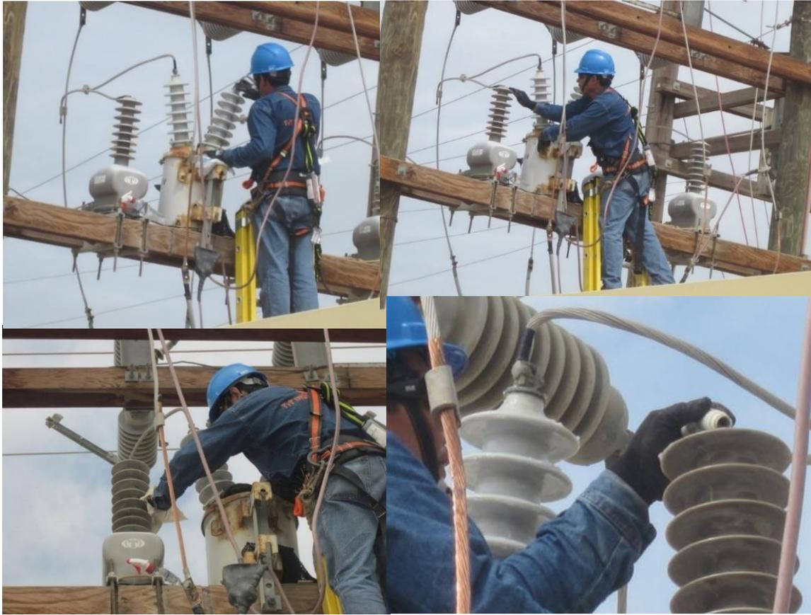
**Figura N°20:** Limpieza y Siliconado de Transformadores de Medición. (Energía y Construcción FK , 2021)
