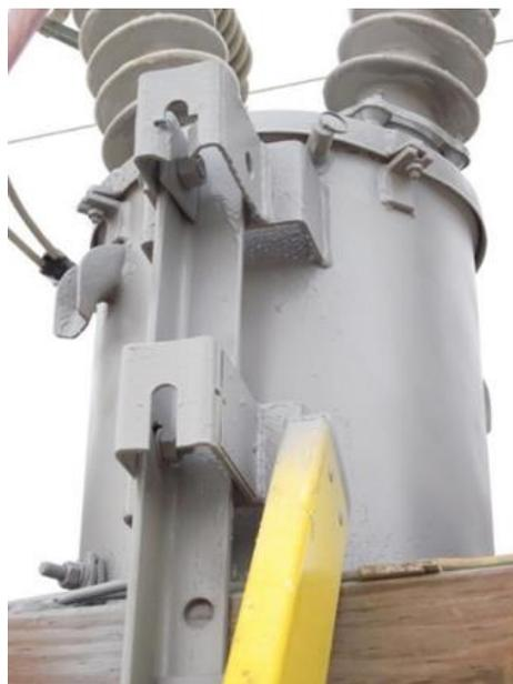
*Figura N°19:* Pintado del transformador de tensión (Energía y Construcción FK , 2021)
