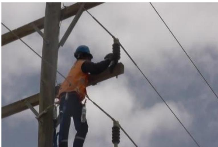
*Figura N°15:* Limpieza de aisladores. (Energía y Construcción FK , 2021)
