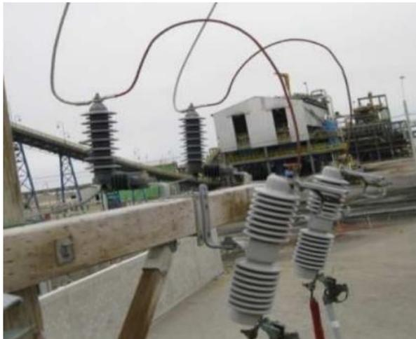
**Figura N°10:** Seccionamiento CUT OUT 22.9 kV. (Energía y Construcción FK , 2021)
