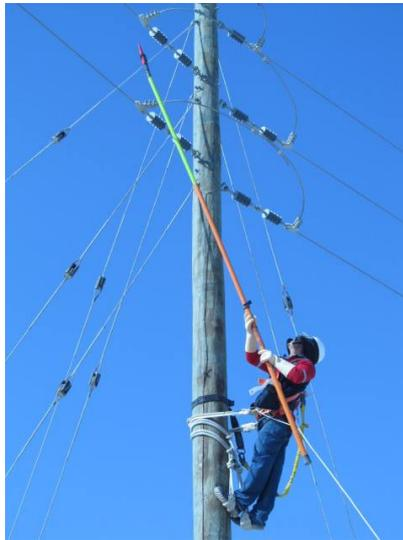
**Figura N°08:** Verificación de la Ausencia de tensión. (Energía y Construcción FK , 2021)
