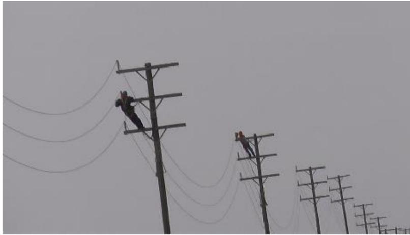
**Figura N°16:** Limpieza de ferretería en estructura de la LT 22.9 KV (Energía y Construcción FK , 2021)
