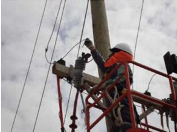
**Figura N°11:** Reparación de elementos de ferretería 22.9 kV Vista 01. (Energía y Construcción FK , 2021)
