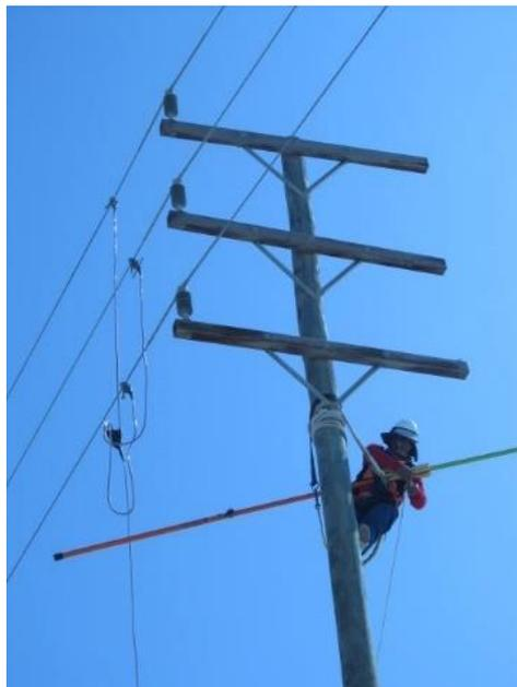
**Figura N°09:** Instalación de puestas a tierra temporal. (Energía y Construcción FK , 2021)
