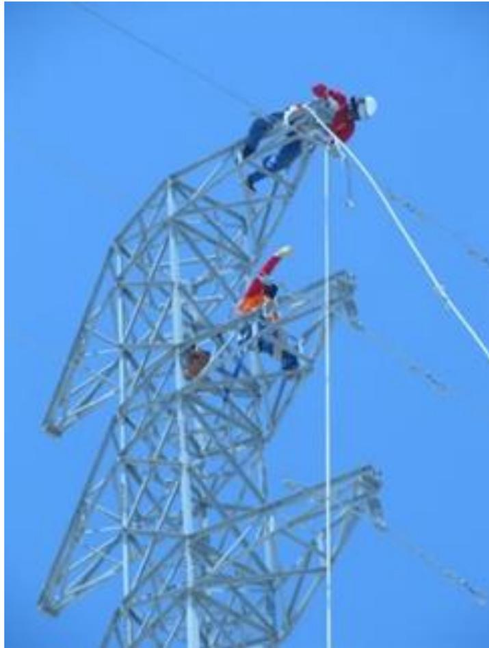
**Figura N°13:** Limpieza en la Torre de la LT de 22.9 KV. (Energía y Construcción FK , 2021)
