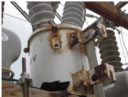
*Figura N°18:* Transformador de tensión corroído (Energía y Construcción FK , 2021)
