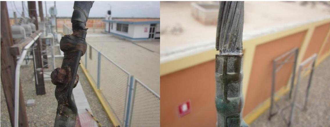
**Figura N°21:** Cambio de conectores (Energía y Construcción FK , 2021)
