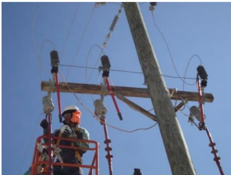
**Figura N°12:** Reparación de elementos de ferretería 22.9 kV Vista 02. (Energía y Construcción FK , 2021)
