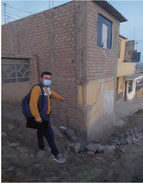
FOTO N° 20: Evaluación de la vivienda ubicada en Jr. Áncash Mz. F Lt. 26
