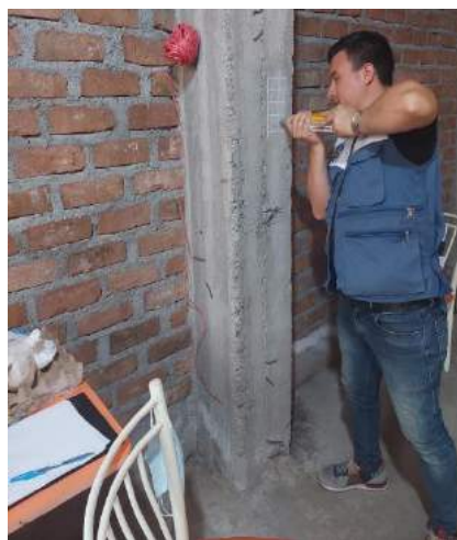
Figura 4 Ensayo de esclerometría aplicado a columna
