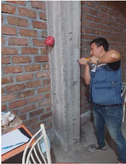
Figura 8 Realizando de esclerometría en la vivienda de Jr. Áncash Mz. F Lt. 8
