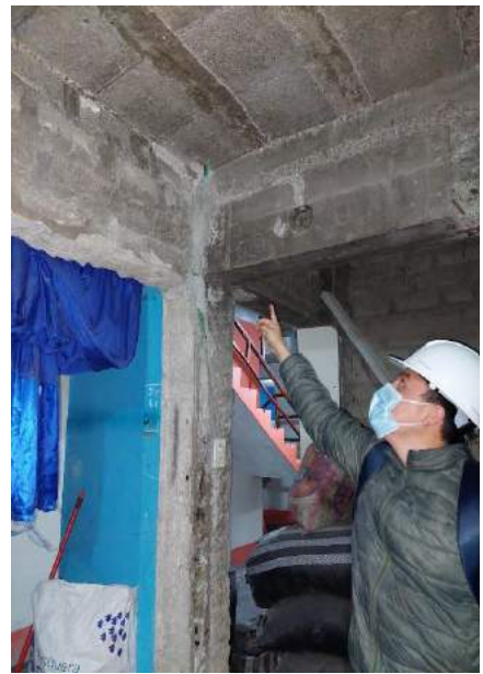
FOTO N° 14: Fallas de la vivienda Jr. Los Ángeles Mz. A Lt. 7, en donde se evidencia daños en una de las vigas
