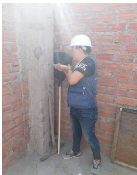
FOTO N° 7: Esclerometría aplicada a la columna en la vivienda 1 que está ubicada en Jr. Los Alamos Mz. N Lt. 6
