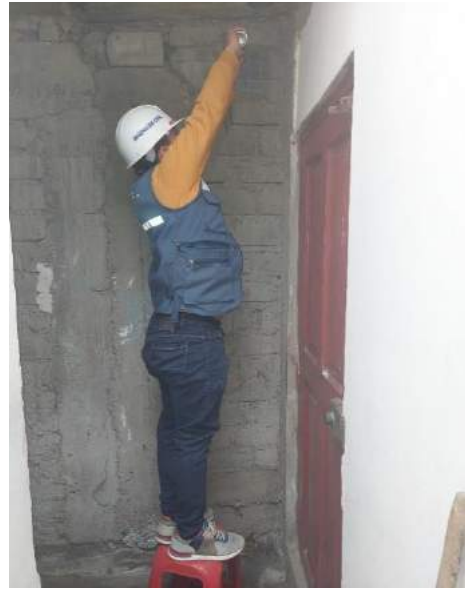
FOTO N° 11: Esclerometría aplicada a la viga de la vivienda 3 en Jr. Los Ángeles Mz. A Lt. 7
