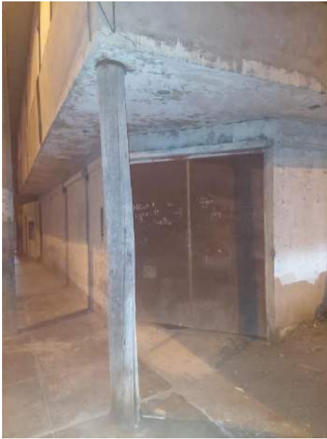
FOTO N° 15: Fachada de la vivienda evaluada que está ubicada en Jr.
