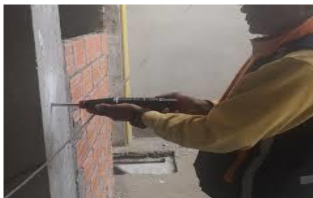
Figura N°7: Ensayo de esclerometría
