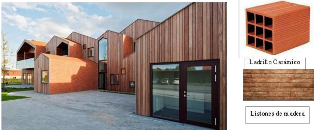
*Figura 19.* Materiales implementados en la edificación.
