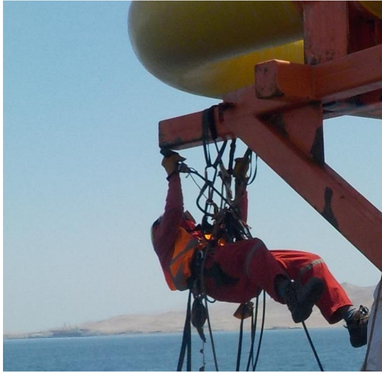
Figura 4: Posición del tronco en trabajo de limpieza mecánica en altura
