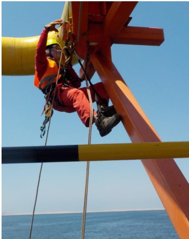
Figura 6: Posición de piernas y brazos en trabajo de limpieza mecánica en altura.
