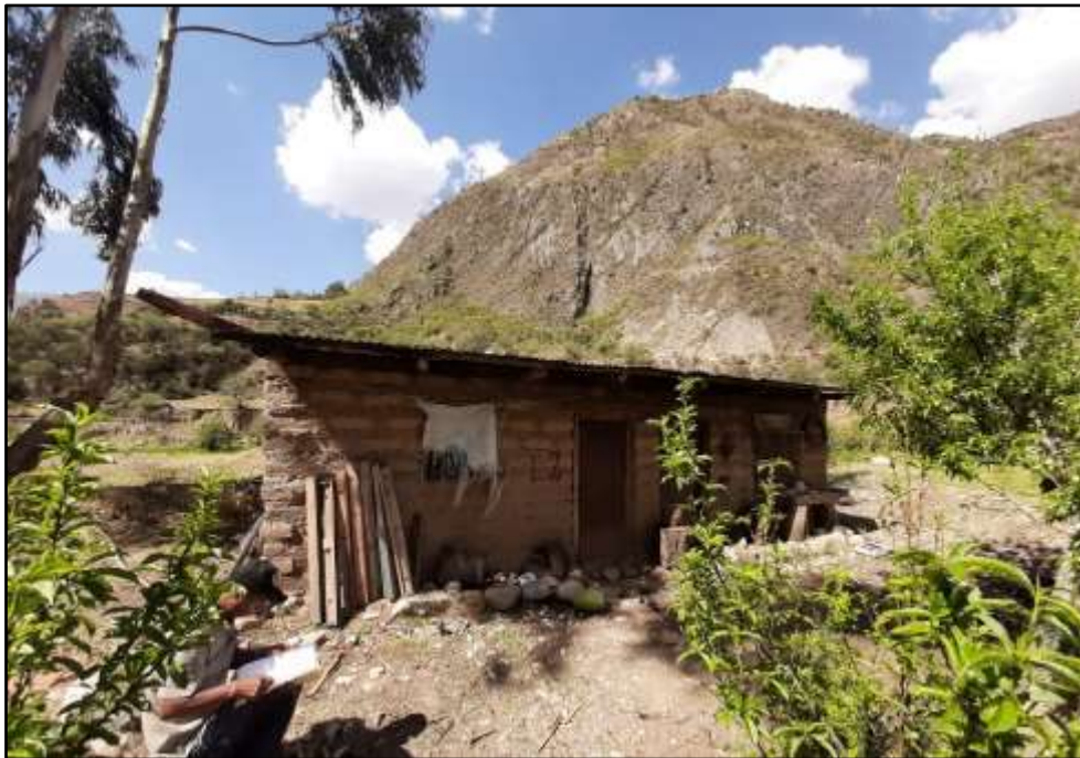
Figura 458. Vivienda beneficiada de adobe, lote N°2 de la localidad Accobado. Fuente: Elaboracion propia
