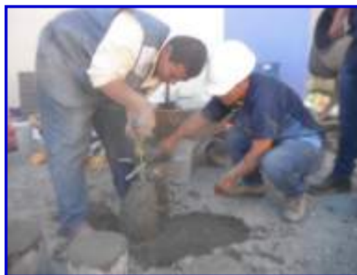
Foto 60. El asentamiento medido resultó 3.50", resultando dentro del rango esperado.
