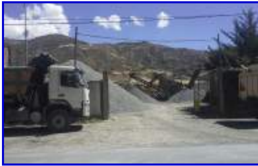
Foto 10. Se muestra la entrada de la planta chancadora “El Tarmeño”, ubicada en la localidad de Taclán en la Carretera Huaraz – Pativilca S/N Km.02.
