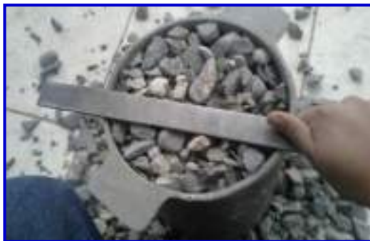
Foto 37. Se observa la finalización del enrasado.
