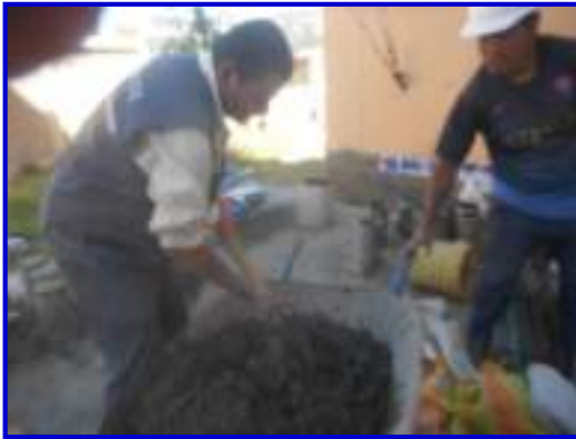
Foto 61. Después de la prueba del slump se colocó la mezcla sobre el bugui.
