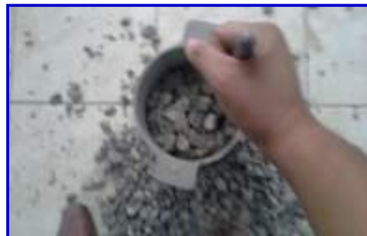
Foto 40. Se observa el compactado de la 2da capa.
