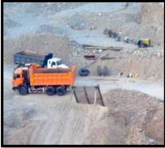
Figura 9: Extracción del agregado Fino.
