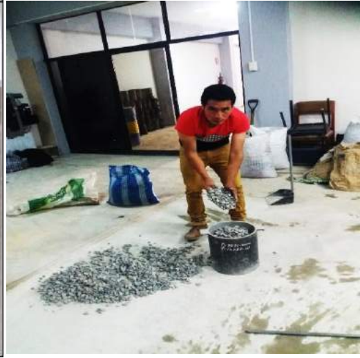
Figura N°14: Llenado del Confitillo. Fuente: Elaboración Propia
