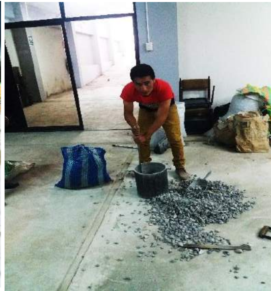
Figura N°18: Varillado del Confitillo Fuente: Elaboración Propia
