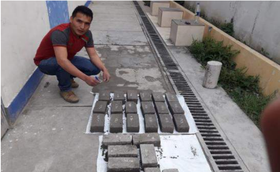
Figura N°47: Fraguado del adoquín Fuente: Elaboración propia
