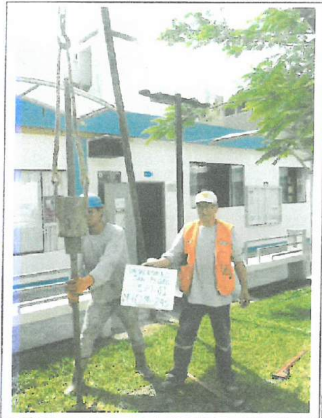
Foto N°03: Vista del SPT-01, prueba de resistencia la penetración de 2.00 a 2.45m.
