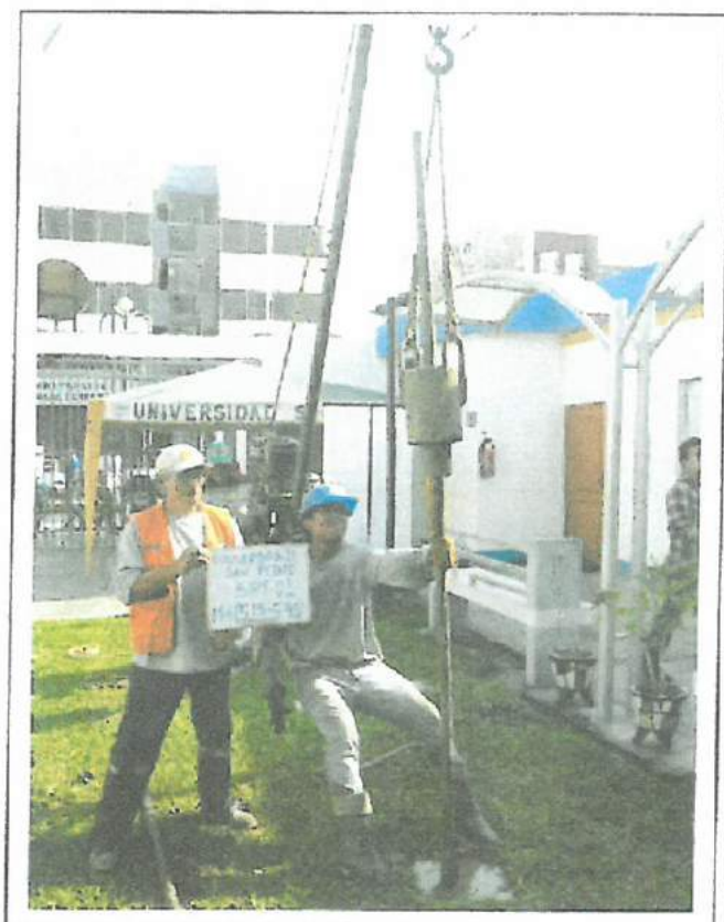
Foto N°07: Vista del SPT-01, prueba de resistencia la penetración de 5.00 a 5.45m.
