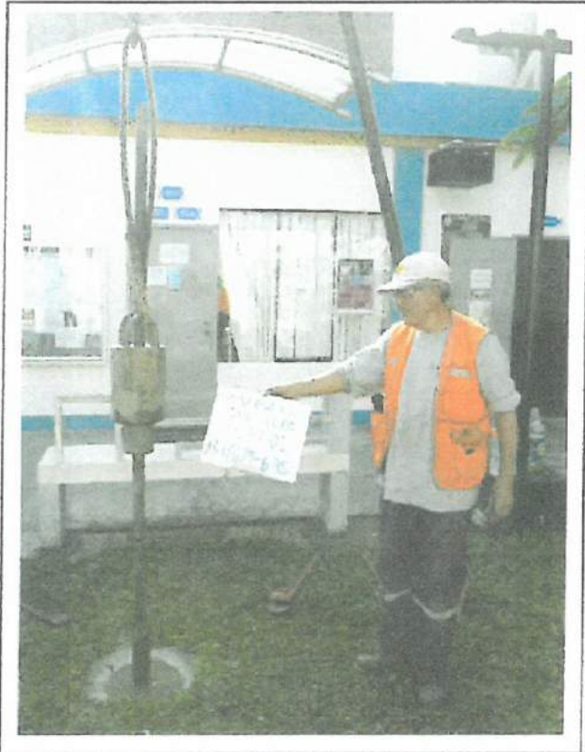
Foto N°09: Vista del SPT-01, prueba de resistencia la penetración de 6.00 a 6.45m.
