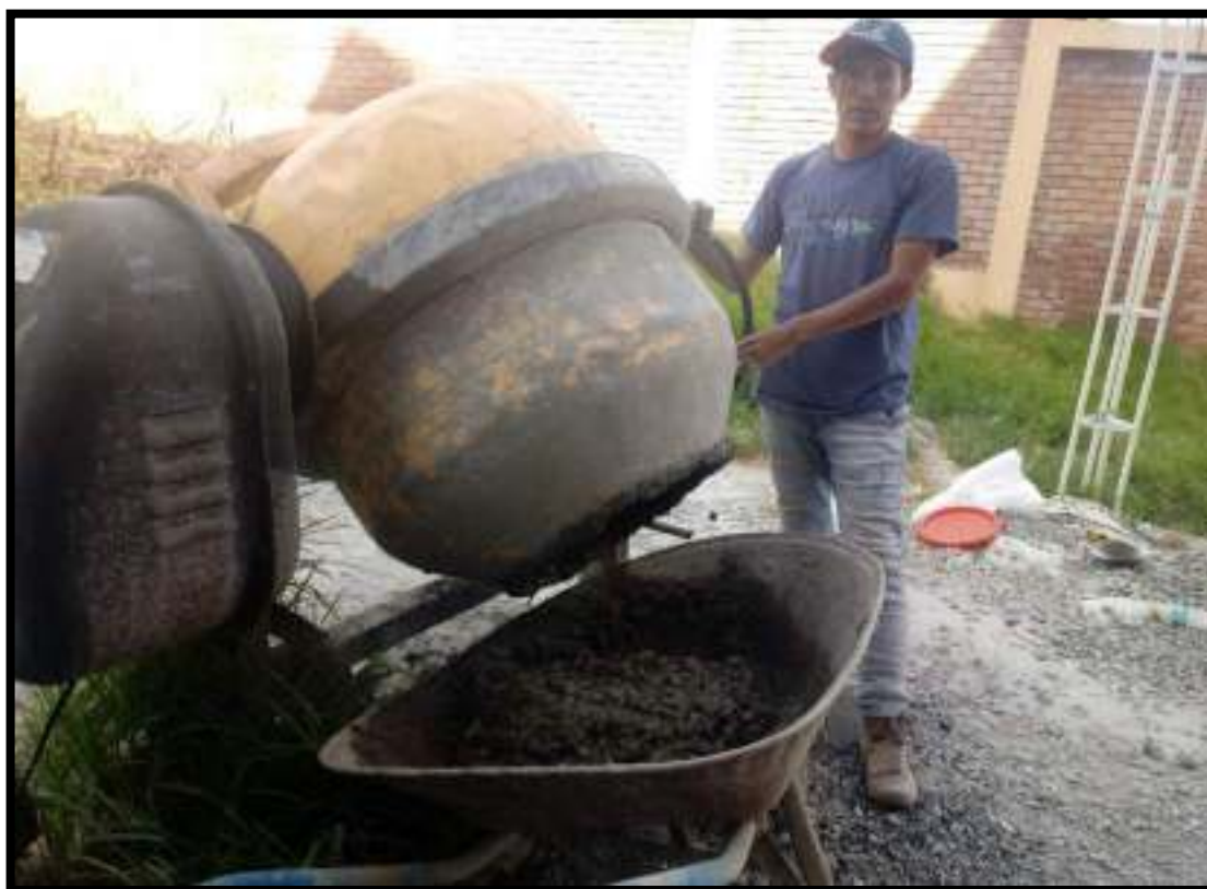
Foto 30: preparando el concreto.
