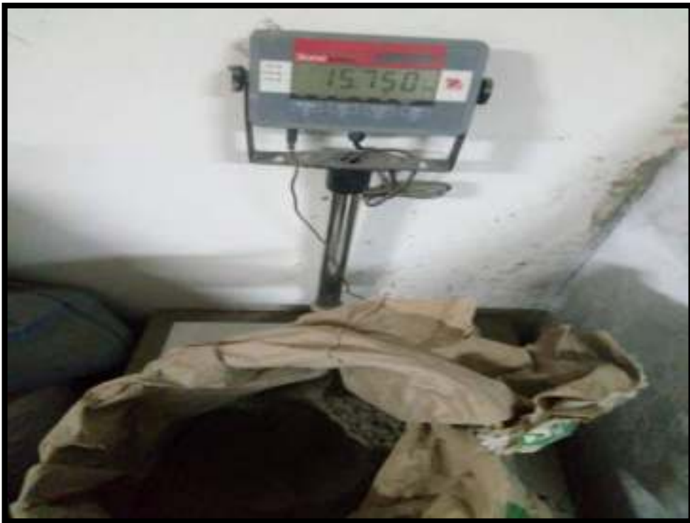
Foto 27: pesando el cemento para la dosificación
