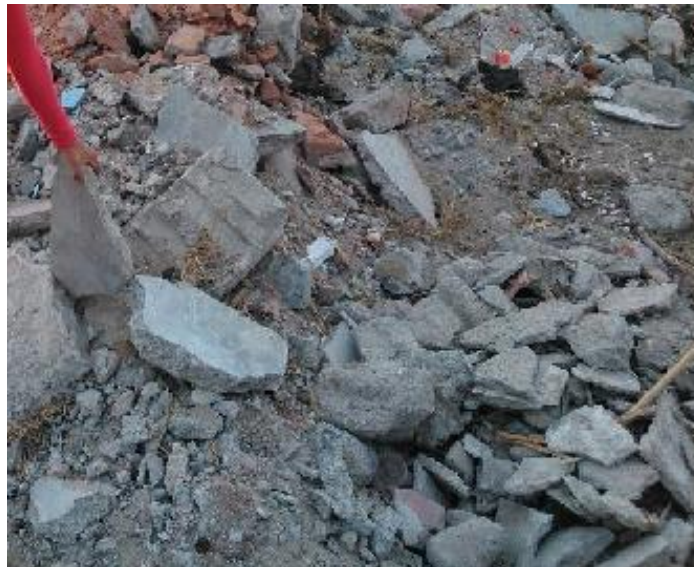
Foto 2: Residuos de construcción y demolición en AA.HH. Villa María
