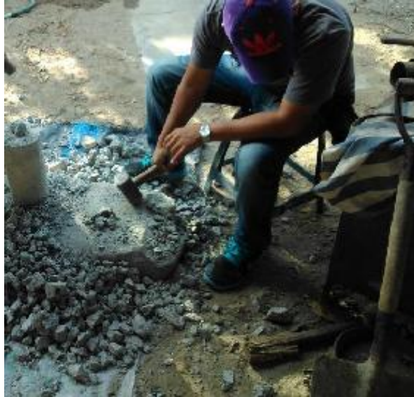
Foto 5:Triturado del concreto reciclado
