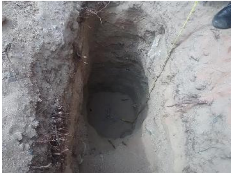
Foto 9:Zanja a 1.60 m de profundidad- Pasaje 36- Villa Hermosa – Nvo. Chimbote
