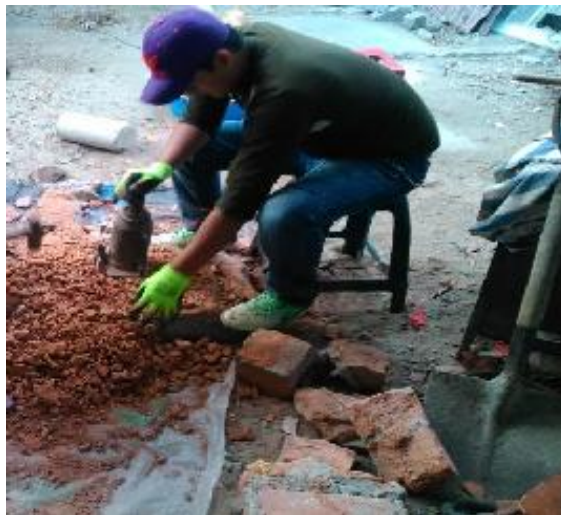
Foto 6:Triturado del ladrillo de arcilla reciclado
