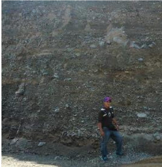
Foto 30:Material granular para sub-base
