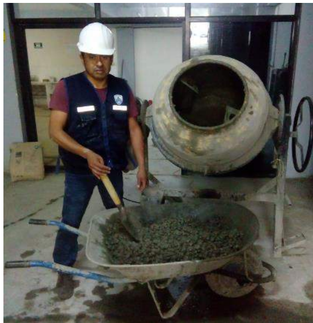
FIGURA 22: Elaboración de la mezcla.
