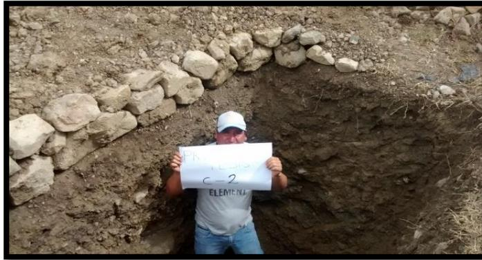
Foto 10: Excavación de calicata N°2
